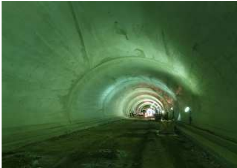
라이닝 콘크리트 현황
