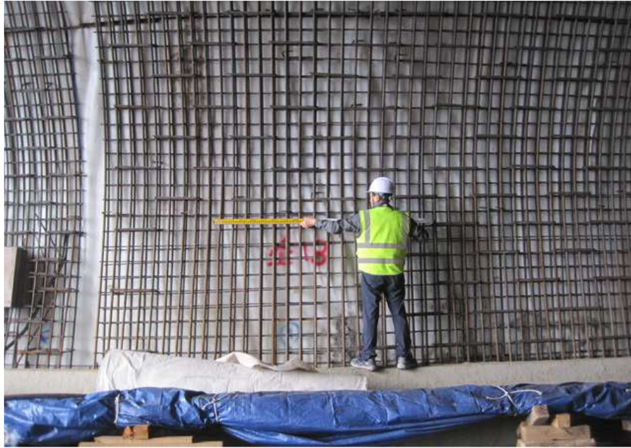
철근 배근 현황
