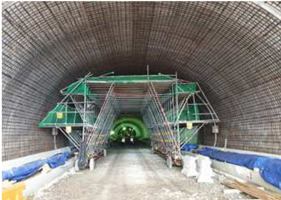
철근 작업 가시설 현황
