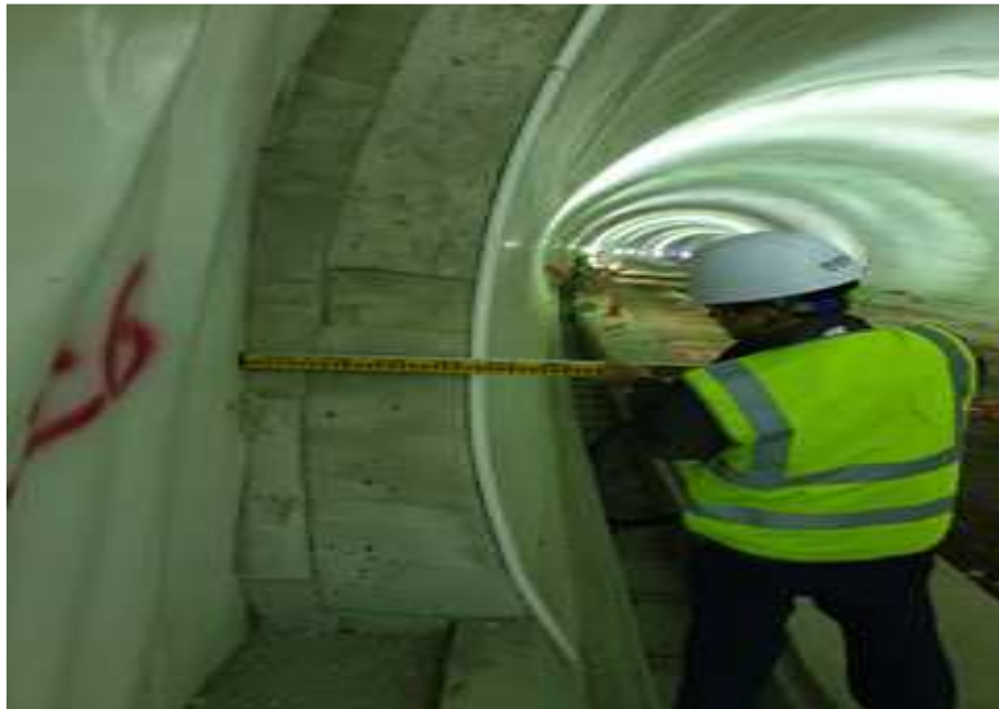
라이닝 콘크리트 현황
