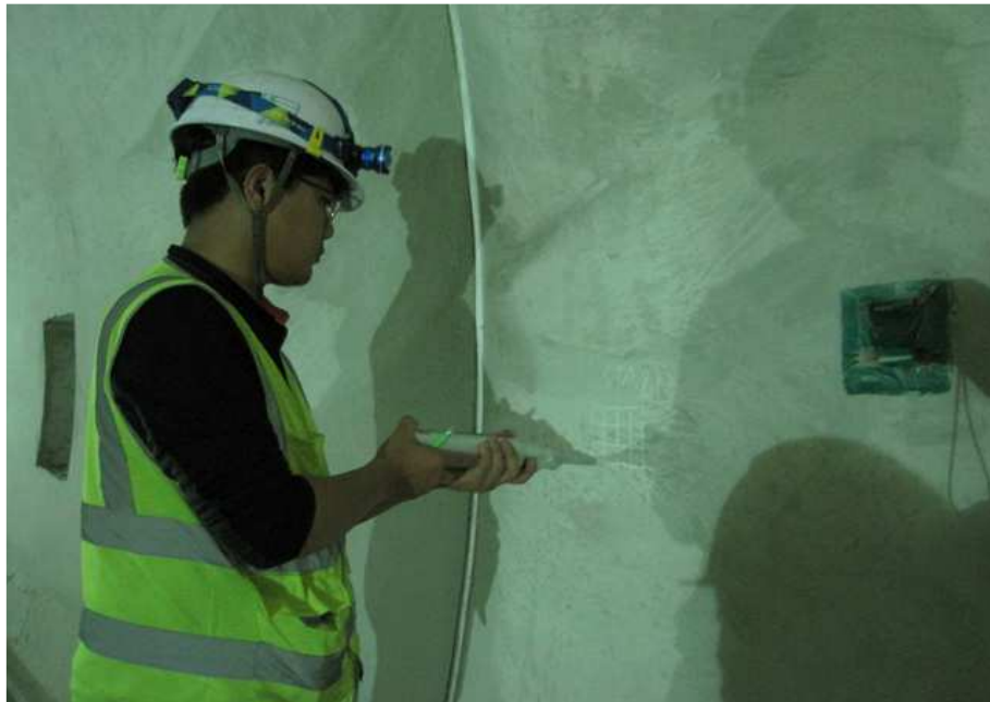
라이닝 콘크리트 강도 측정
