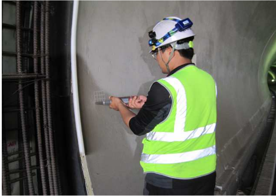
라이닝 콘크리트 강도 측정
