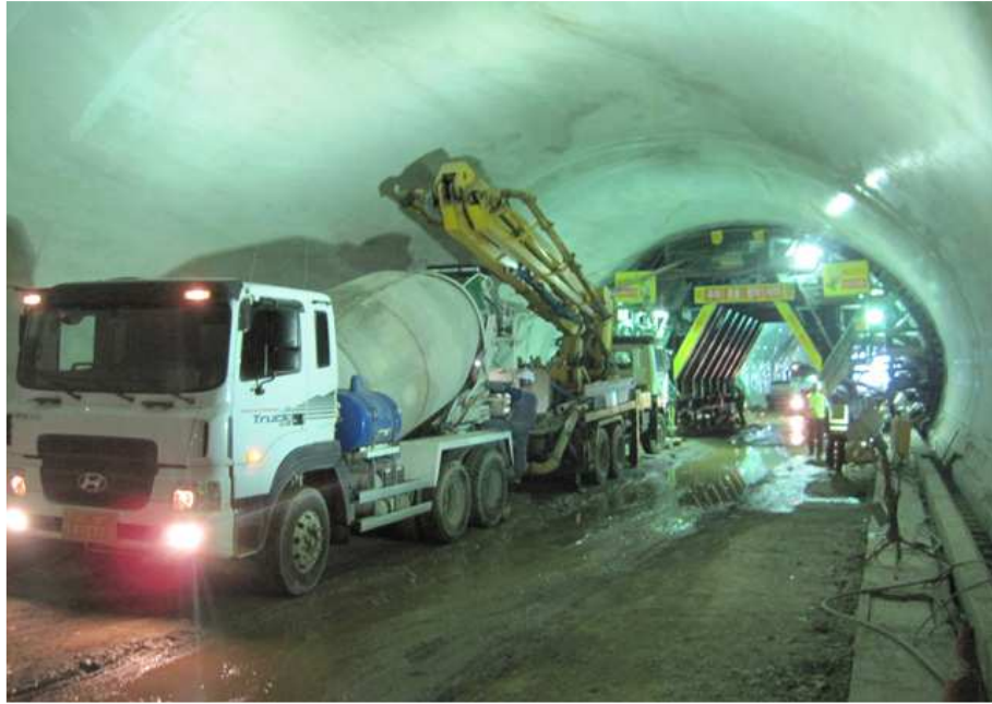
라이닝 콘크리트 현황
