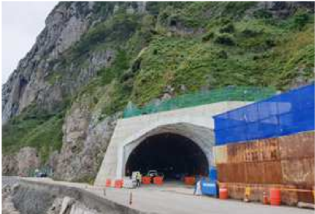
북면터널 시점부 갱구 전경
