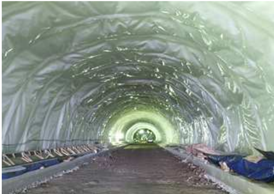
방수쉬트 시공 현황
