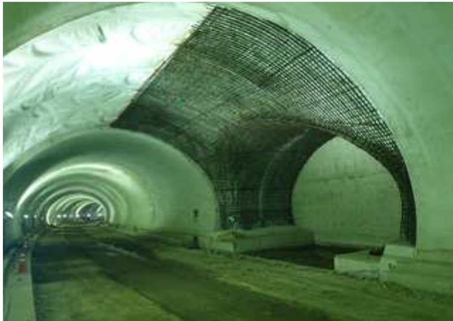
철근 조립 및 배근 전경
