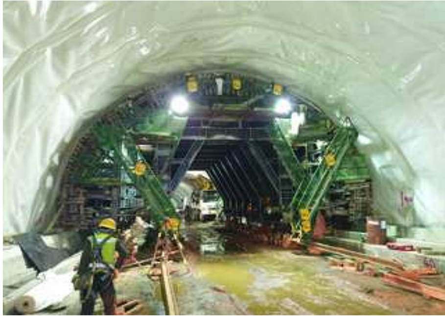
방수쉬트 시공 현황
