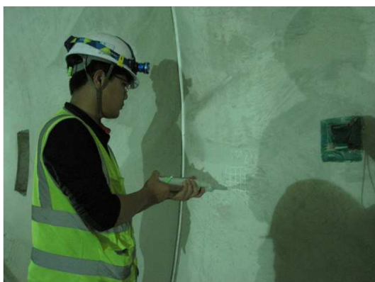
라이닝 콘크리트 강도 측정
