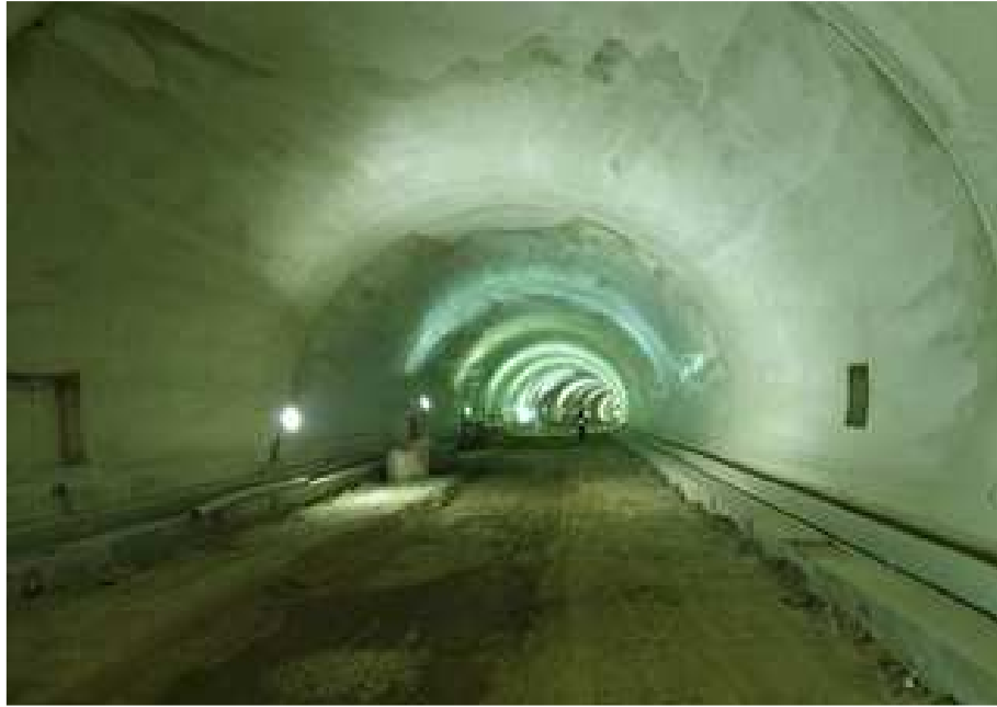
라이닝 콘크리트 현황
