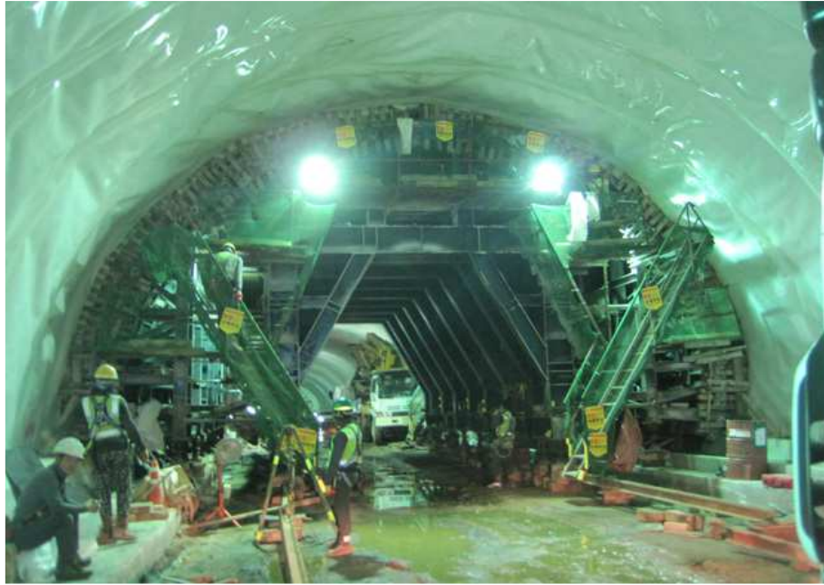
라이닝 콘크리트 타설 가시설 현황
