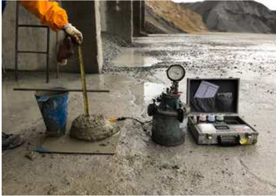
라이닝 콘크리트 슬럼프 시험
