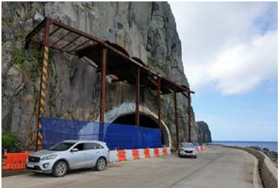
북면터널 종점부 갱구 전경
