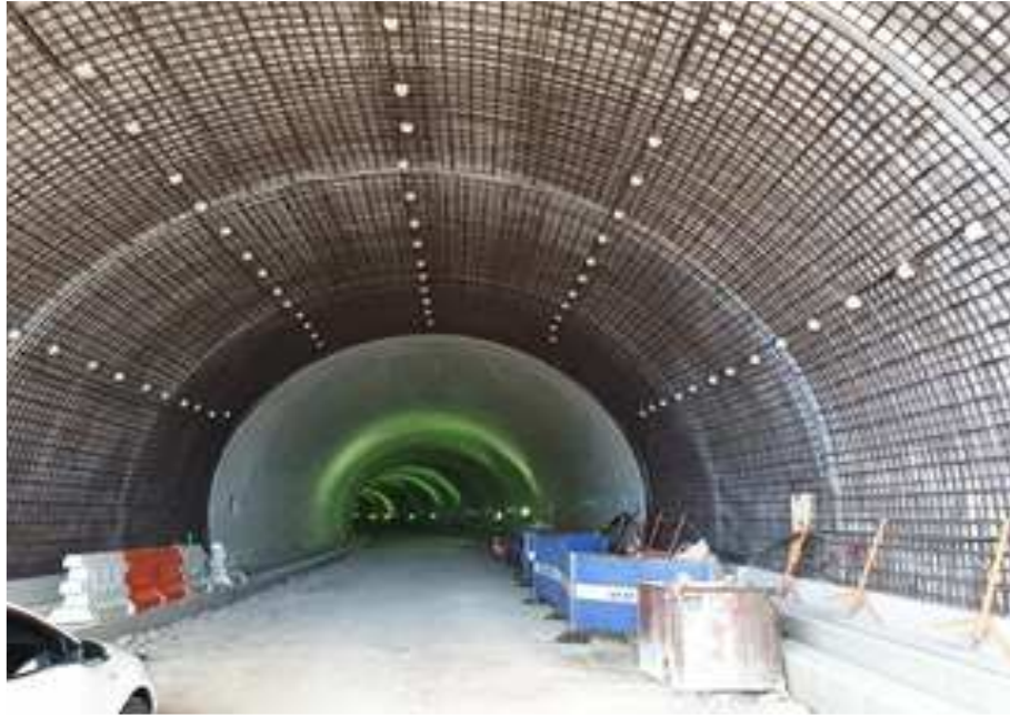
철근 조립 및 배근 전경
