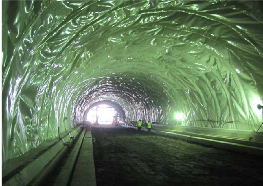
방수쉬트 시공 현황
